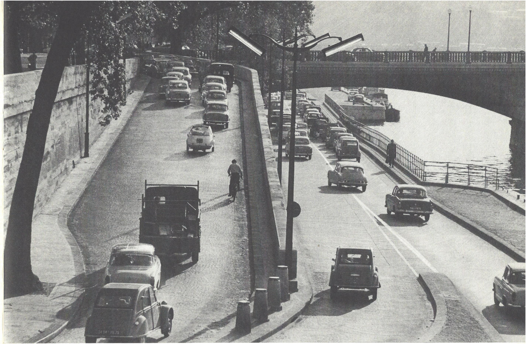
L'embranchement du pont des Invalides
